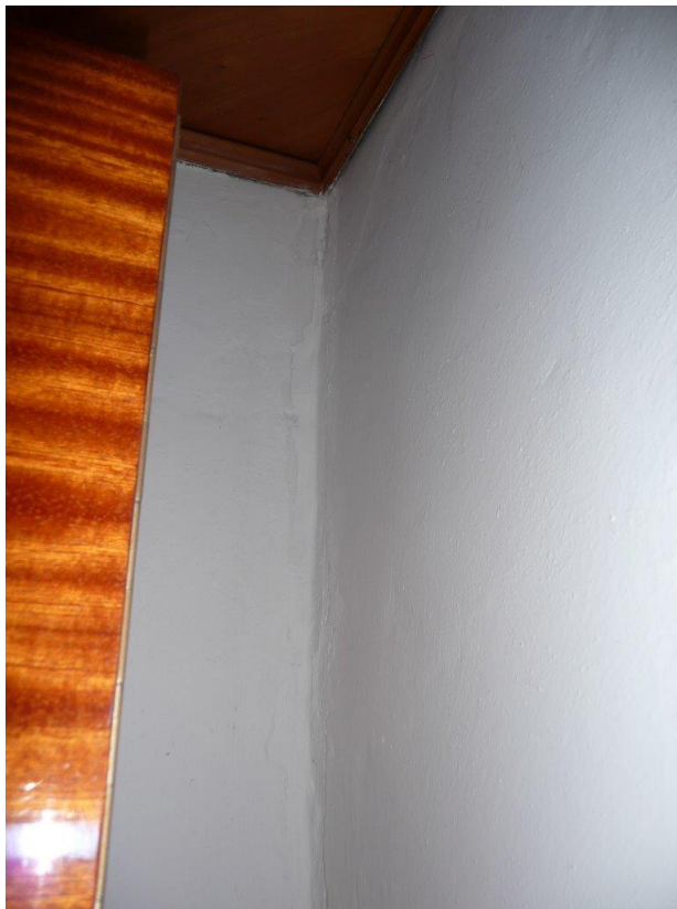
Foto č. 64a, 65 – Pokoj v 1. patře – svislá trhлина v rohu
