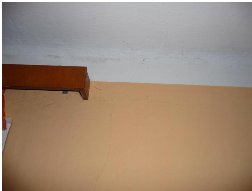
Foto č. 59 – Pokoj v 1. patře – trhlinky na stěnách
