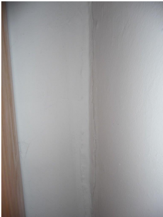
Foto č. 64a, 65 – Pokoj v 1. patře – svislá trhлина v rohu
