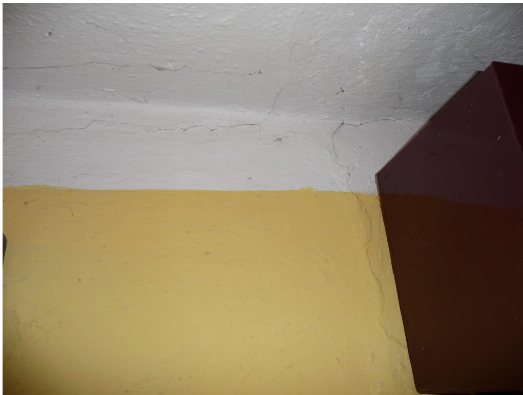
Foto č. 69 – Koupelna v 1. patře - trhliny
