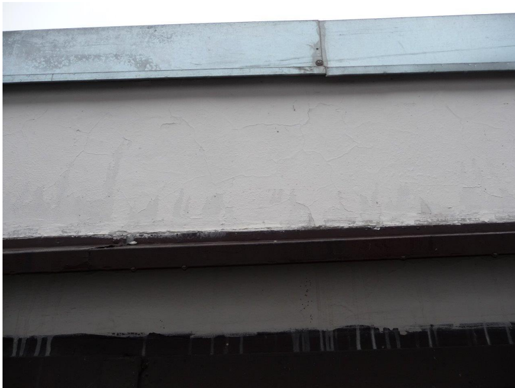
Foto č. 124 – Garáže - pohled nad vrata - trhlínky
