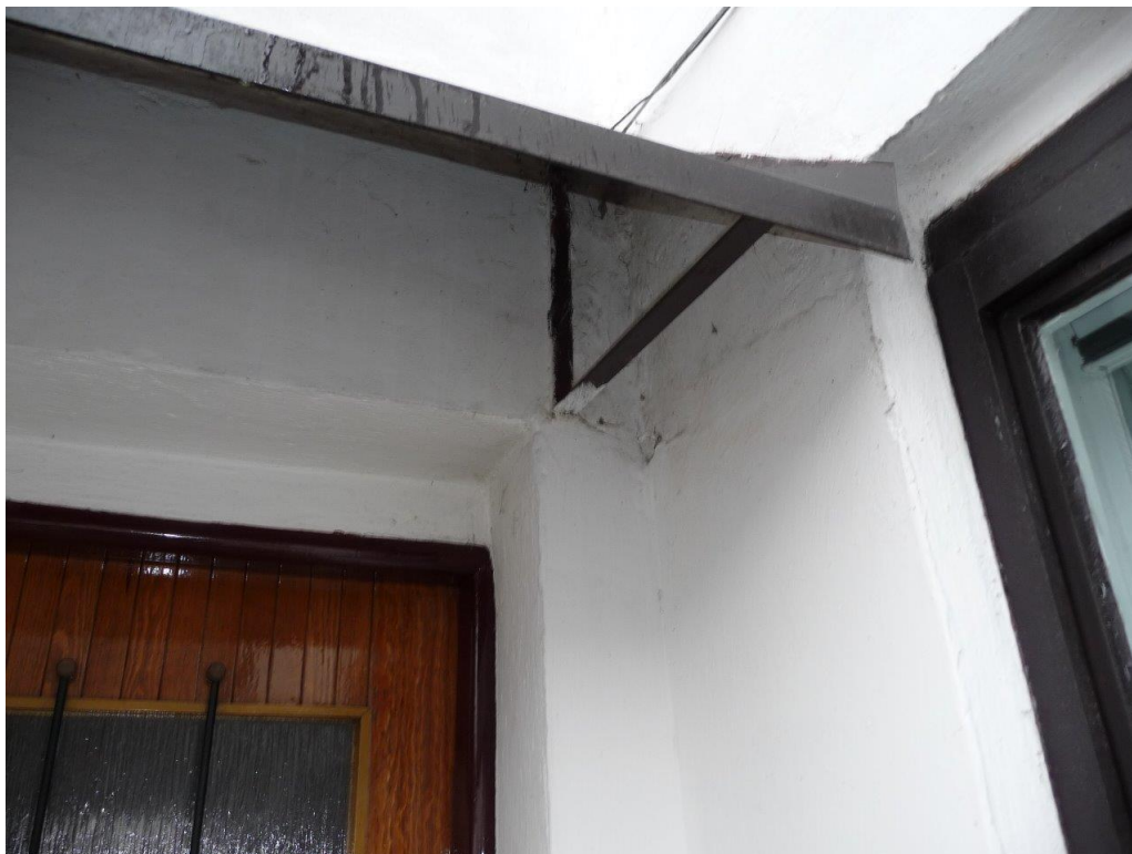
Pohled jižní – trhlina nad vstupem do objektu
