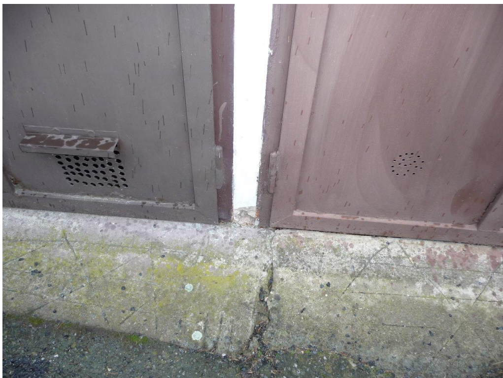
Foto č. 82 – Garáže – trhlina v betonovém nájezdu
