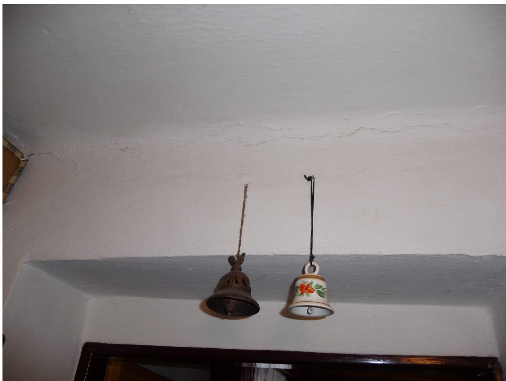
Foto č. 64 – Kuchyně v 1. patře – trhliny nade dveřmi
